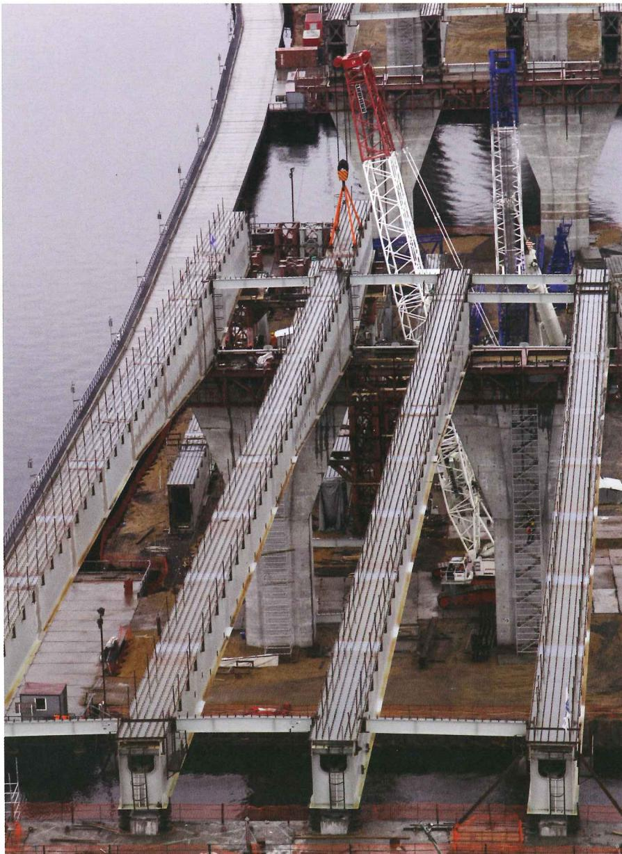
ты. Проект производства работ предполагает несколько вариантов сборки металлических конструкций. В настоящий момент строители применяют метод сборки, при котором пролет монтируется отдельными элементами. Вначале при помощи двух кранов монтируются и поднимаются наверх главные балки. Затем к ним поочереди присоединяются средние балки, к которым следом пристыковывается набор из поперечных балок. Такой вариант сборки имеет свои недостатки — с легкой и гибкой конструкцией довольно сложно работать.
